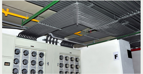
電導管工程 Electrical engineering
