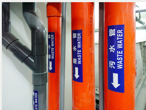
下水道工程 Sewer Engineering
